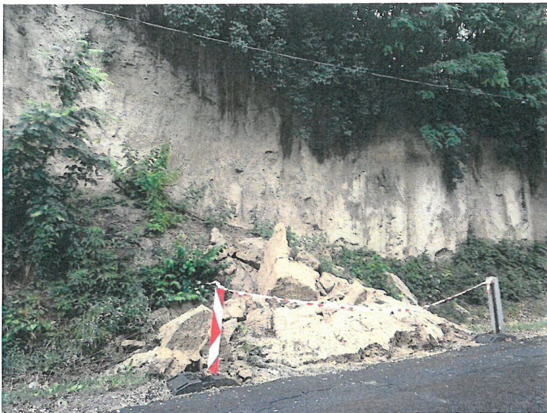
12. kép: Löszfal omlás után
