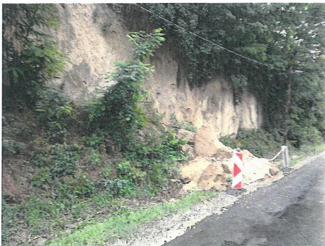
15. kép: Lössfal omlás után
