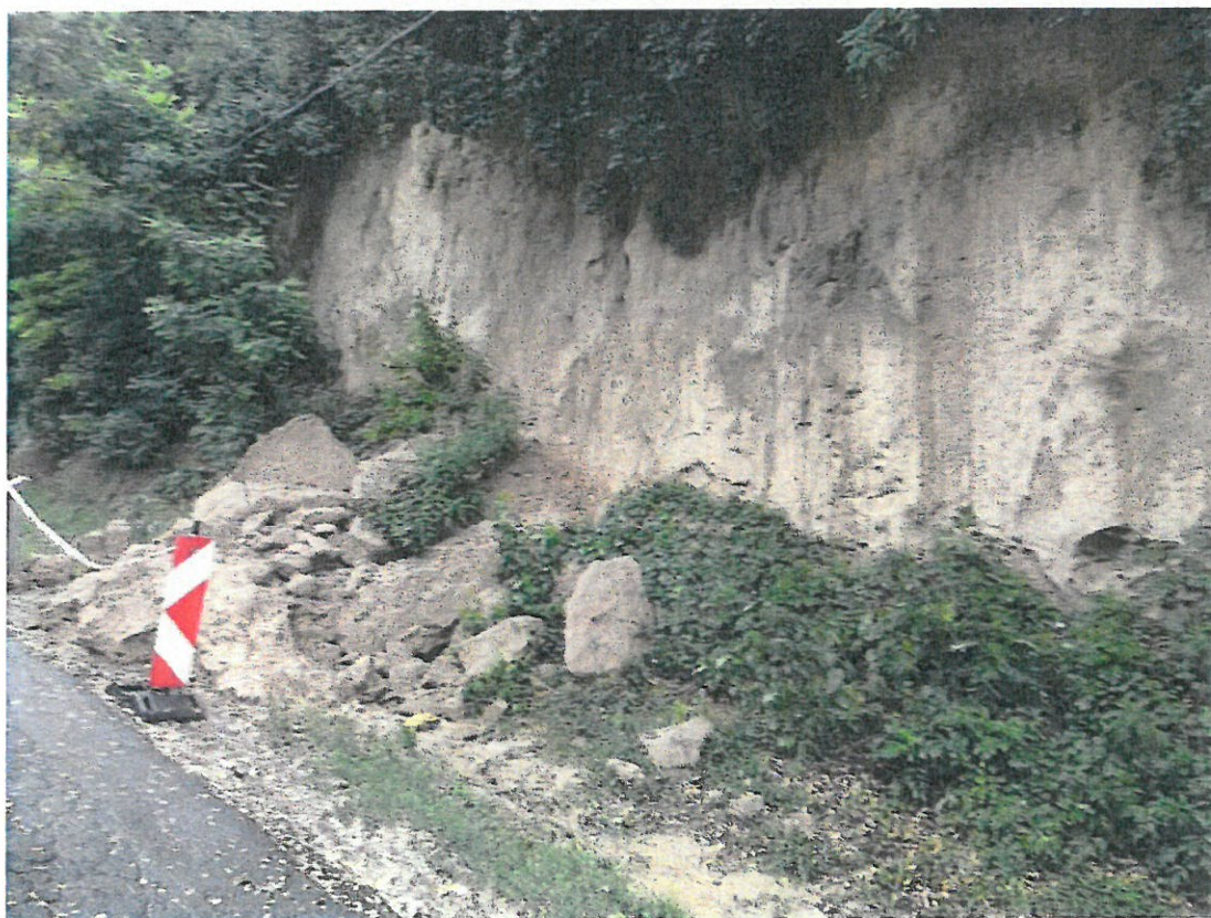
13. kép: Löszfal omlás után
