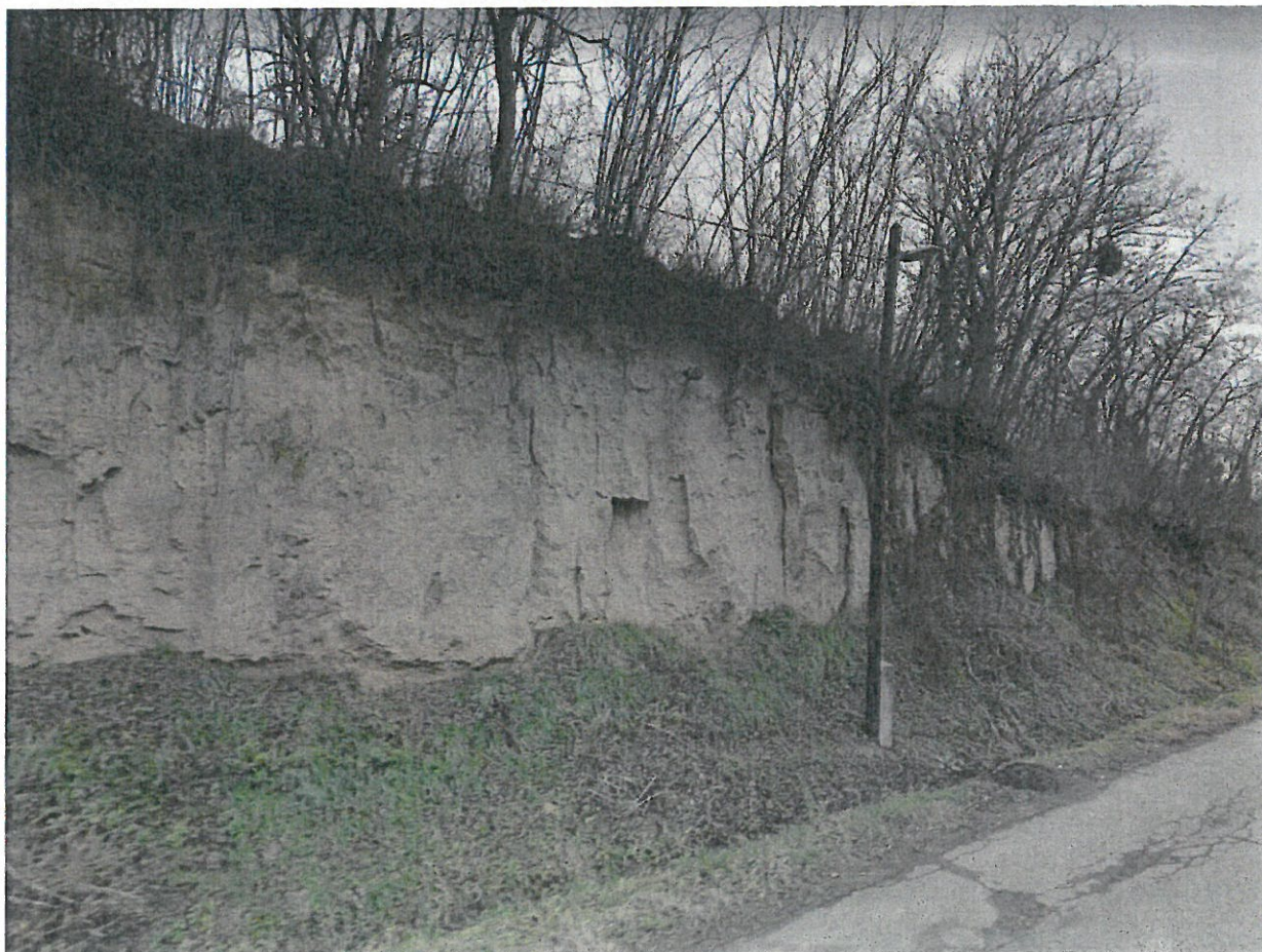
11. kép: Lössfal omlás előtt
