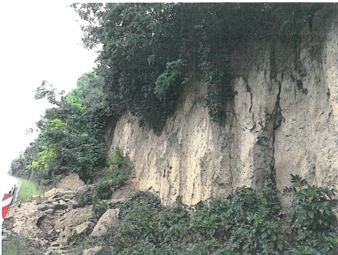
14. kép: Lössfal omlás után
